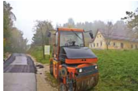
Prenova ceste JP Zgornja Košnica
