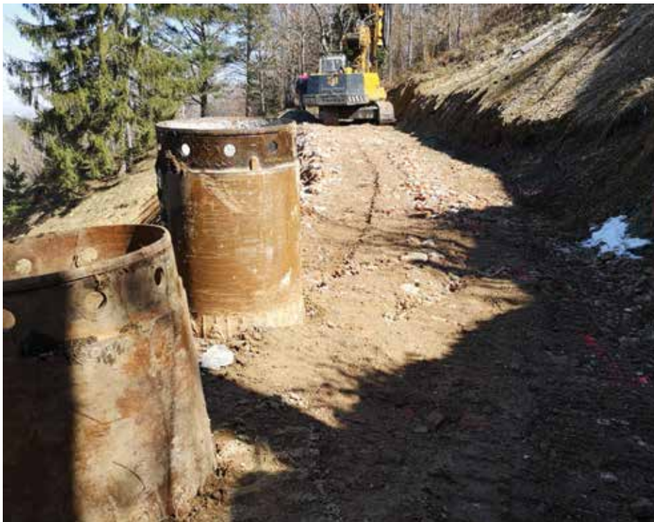
Sanacija plazov v Košnici, ki je že v teku, je zaradi zahtevnega terena in obsega precej velik zalogaj.
